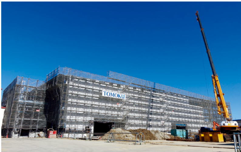
建設中の館林工場
