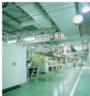
段ボール製造設備
