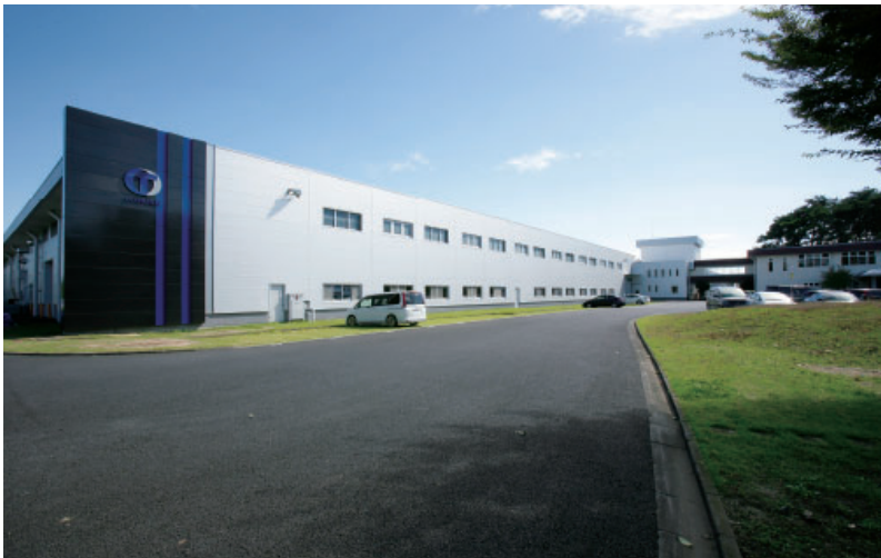
新装なった館林工場
